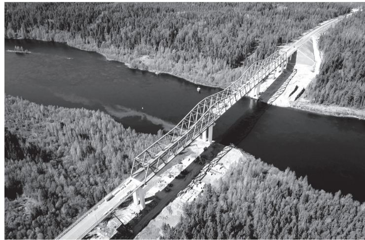
Строительство моста через реку Свирь стало историческим событием
